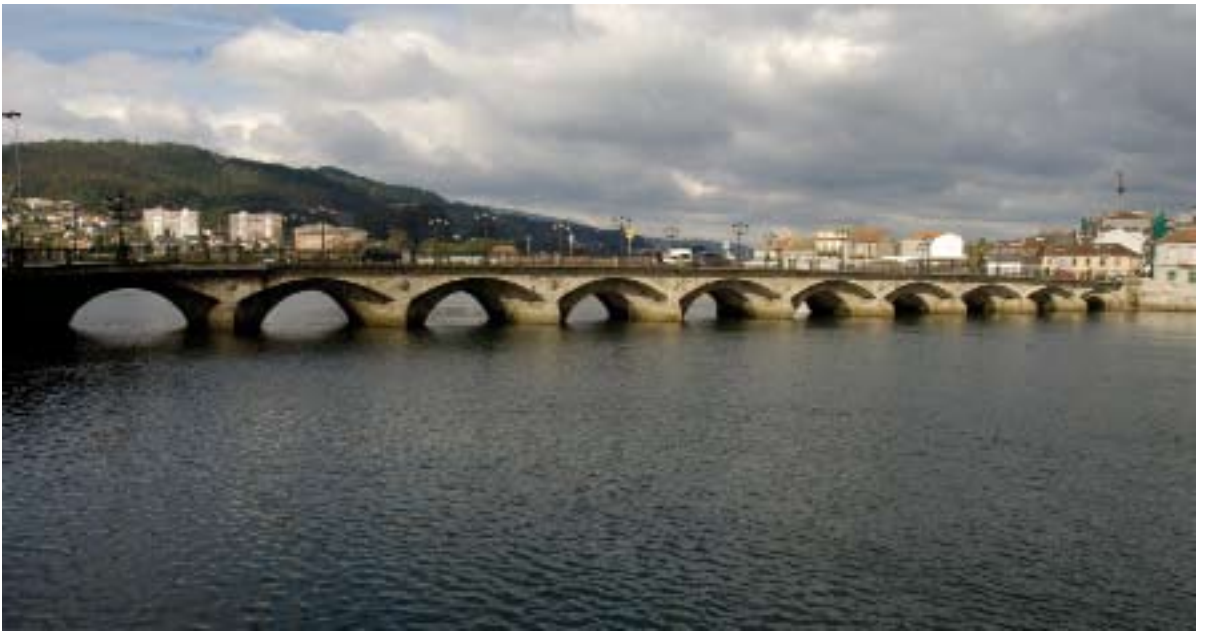
Ponte do Burgo
